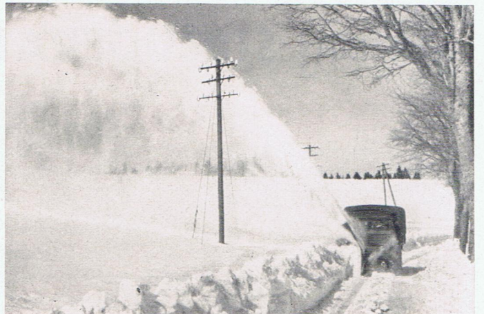
UNIMOG S mit Seitenschneeschleuder (Zapfwellenantrieb)
