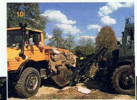
11 Abbau von Sandsäcken an den Deichen
