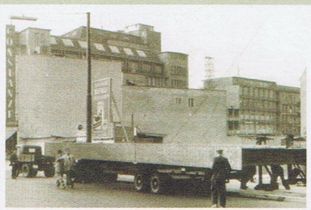
Vielleicht die beeindruckendste Vorführung: Der Unimog zieht eine riesige Stahlträger-Konstruktion für den U-Bahnbau in Berlin. Im Hintergrund steht das Kaufhaus des Westens
