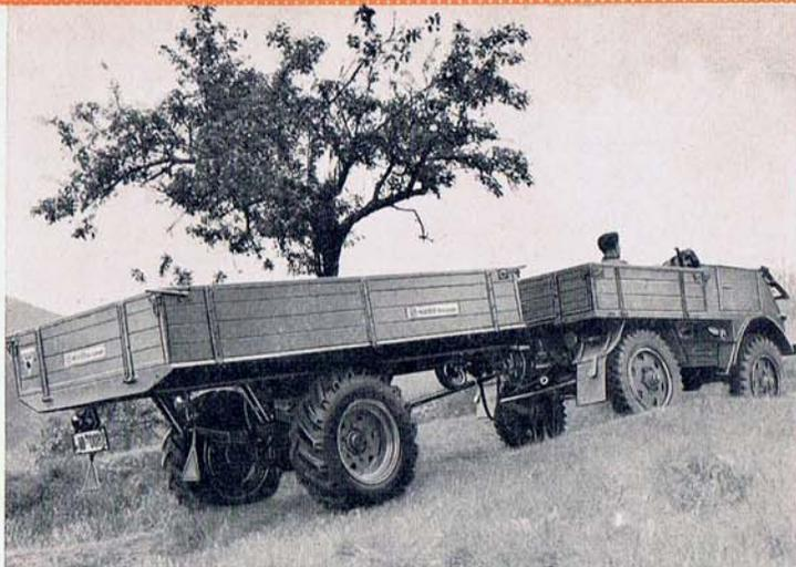
**30** Die durch Zapfwelle angetriebene Achse dieses Spezial-Anhängers bringt die volle Motorenleistung des Zugfahrzeuges an den Boden.
