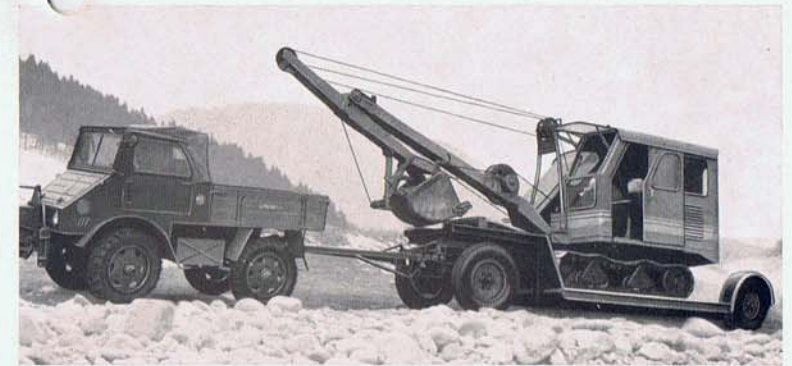
27 Tieflade-Anhänger, Type MTA, Nutzlast 6,5 to, mit UNIMOG. Zwei wirtschaftliche Transporthelfer im Baugewerbe.
