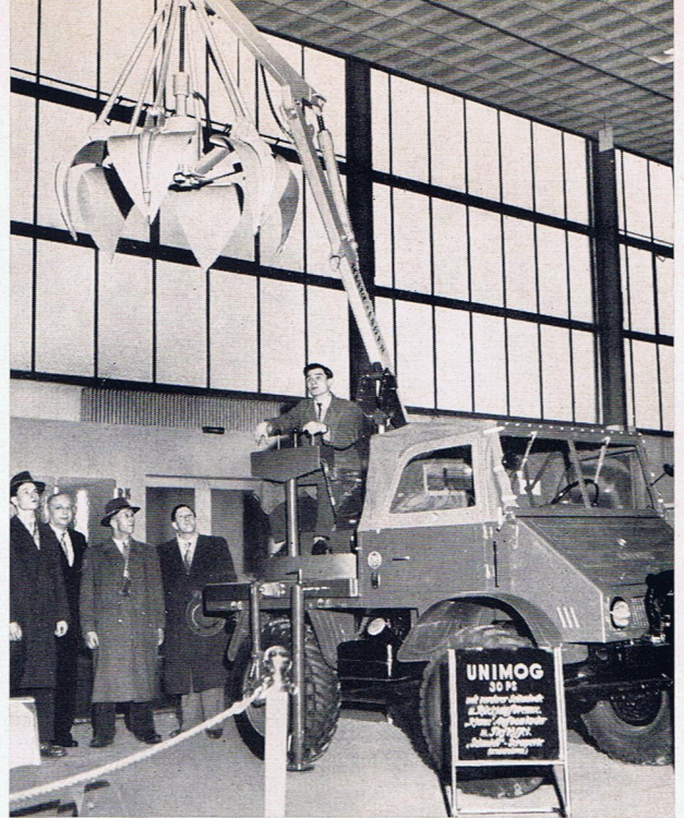
„Det is ne Wucht“, sagten die Berliner, und auch die Fachleute staunten, wie man sieht, wenn der UNIMOG mit dem Klaus Lader vorgeführt wurde. Hier sind dem zum Mist- und Heuladen geeigneten Polyp-Greifer die Erdschaufeln eingesteckt. Der Greifer kann auch gegen einen Tieflöffel zum Grabenziehen und Ausschachten oder gegen andere Werkzeuge ausgetauscht werden.
