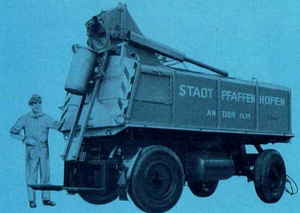
13 UVM, Nutzlast 4,1 to, mit Aufbau und vollautomatisch staubfreiem Zöller-Einschüttaggregat, Fassungsvermögen des Müllbehälters 6 cbm, Antrieb der Schütt- und Kipp-Aggregate durch Druckluft.
