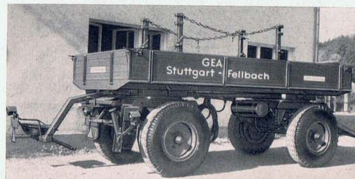
55 ULW, Nutzlast 6,0 to, mit mech. Kipp-Aggregat und abnehmbarer Pritsche, Langholzschemeln und Verladewinden.
