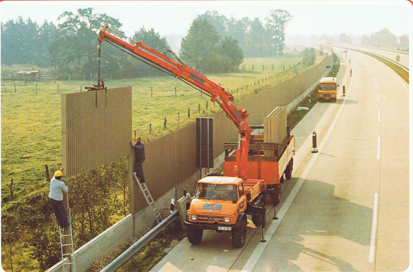
HIAB 965 AW mit Seilwinde auf U 1100 im Montage-Einsatz
