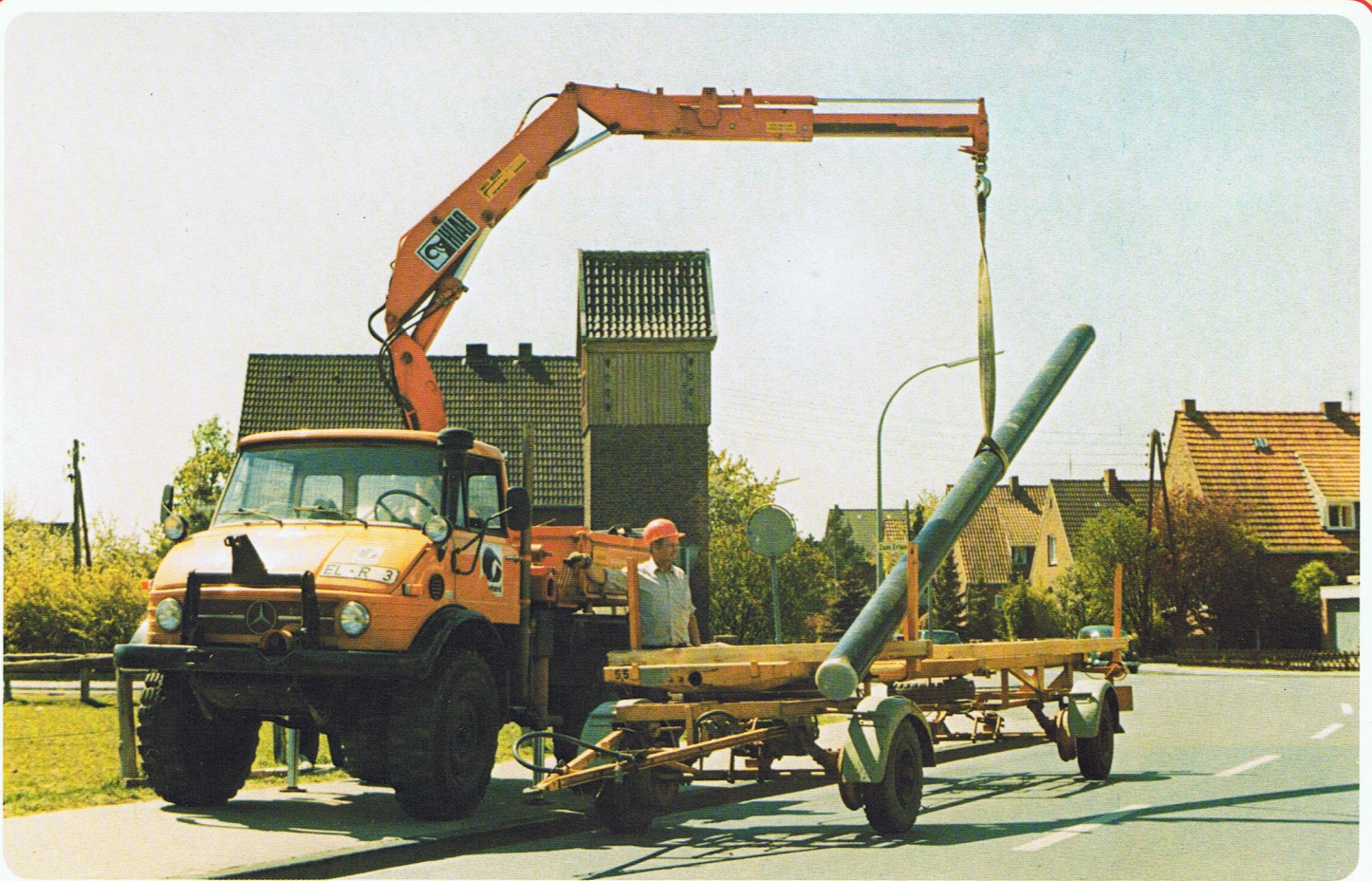
HIAB 650 A beim Rohrtransport
