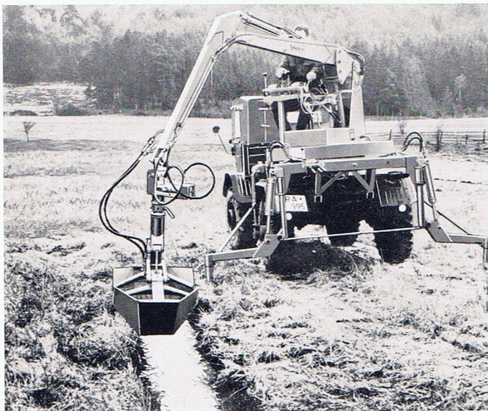
Reinigung von Gräben mit konischem Zweischalengreifer
