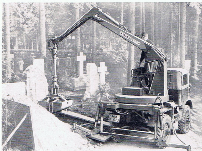
Aushub von Gräbern auf Friedhof
