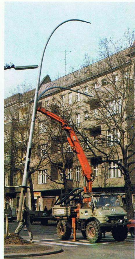
Beim Aufsetzen von Peitschenmasten
