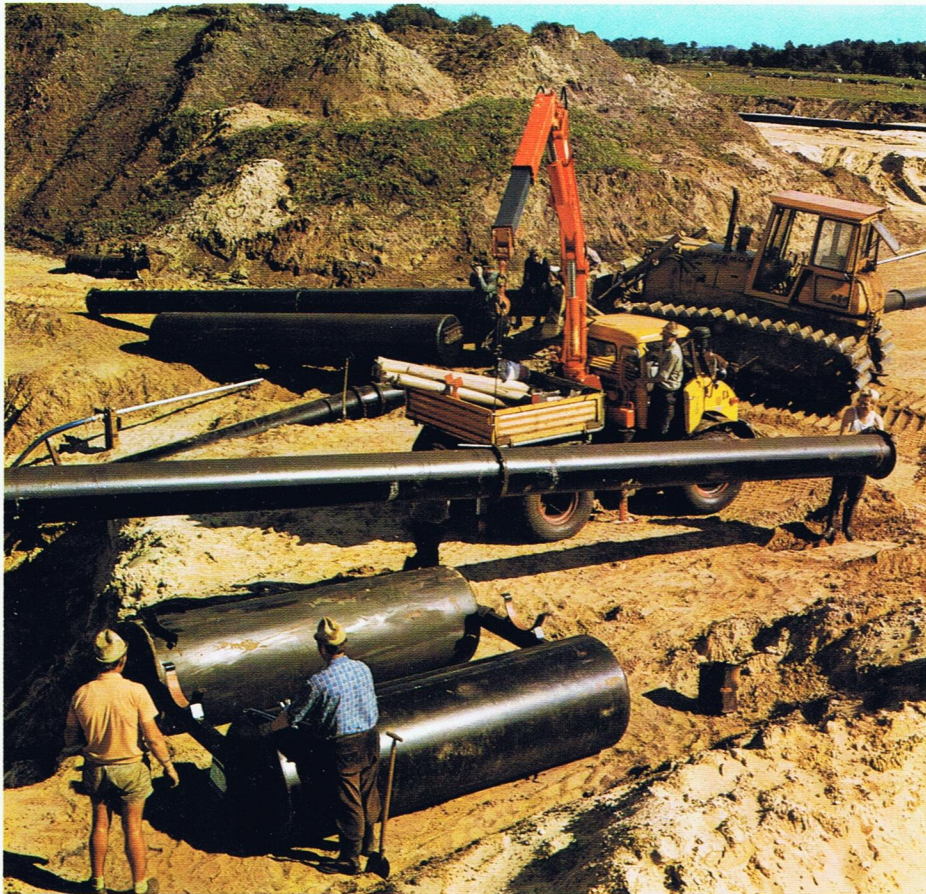
AK 3006 V, aufgebaut zwischen Fahrerhaus und Pritsche, beim Rohrverlegen
