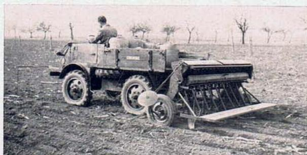
Voraussetzung für rationelles Kartoffellegen ist die laufende Versorgung der Legemaschine mit Saatgut. Sie wird erfüllt durch die Pritsche des UNIMOG, die das Mitführen eines ausreichenden Vorrates an Saatkartoffeln gestattet. Man wird dabei entweder der halb- oder vollautomatischen Maschine den Vorzug geben, je nachdem, ob man vorgekeimte oder nicht vorgekeimte Kartoffeln legen will.
