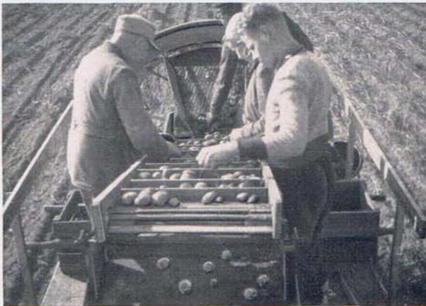
Bei der Verbindung des UNIMOG mit den Vollerntemaschinen wird das Förderband außerdem zum Verleseband, auf dem Steine, kranke Knollen und Krautreste durch einige Personen aussortiert werden können. Da wirtschaftlicher Kartoffel-Anbau fast nur auf leichteren Böden möglich ist, sind die Voraussetzungen für die Verwendung dieser Maschinen, die siebfähige Böden verlangen, im allgemeinen gegeben.
